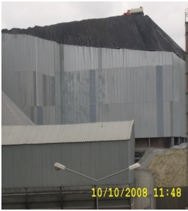
ÇED kapsamında tozuma karşı önlem alınmış kırma eleme tesisi
