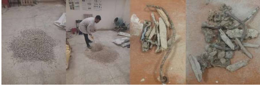
Şekil 6 Beton molozlarından atıkların ayıklanması
